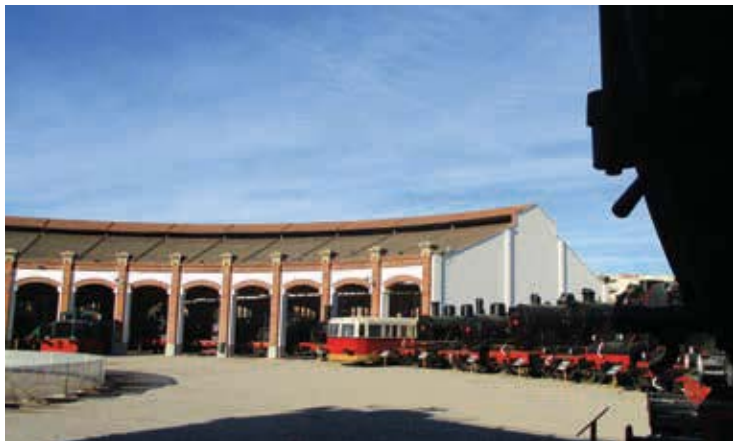
L'ancien dépôt de Vilanova, avec sa rotonde, son pont tournant et ses châteaux d'eau, est devenu un musée des chemins de fer avec une collection particulièrement riche et variée.
